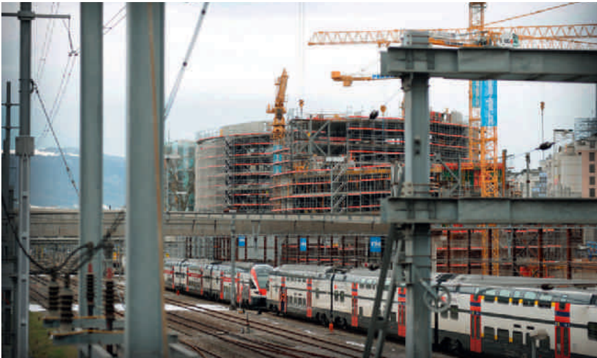
Chantier de la Maison de la paix en février 2013 (© Laurent Guiraud/Tribune de Genève)
