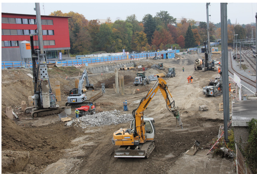
Construction of Maison de la Paix begins, September 2011
